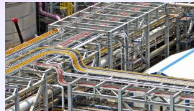
Для монтажа кабельных трасс
