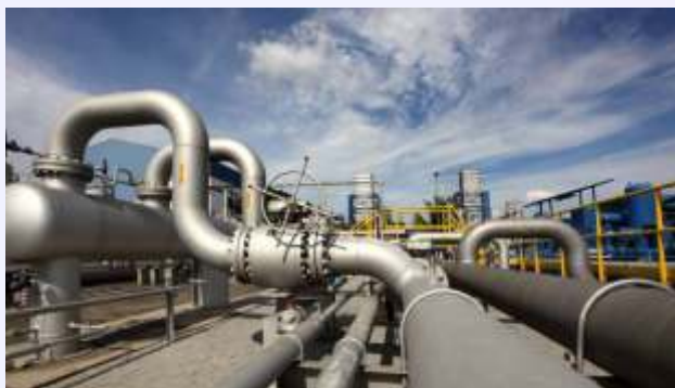
Для монтажа трубопроводов
