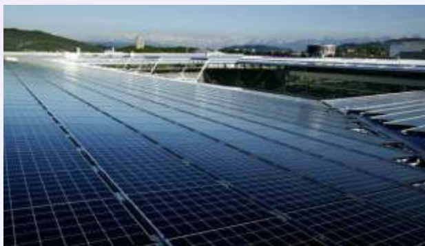
Для монтажа солнечных батарей
